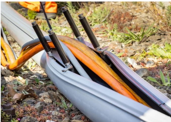
3. Kabel in das Rohr legen
