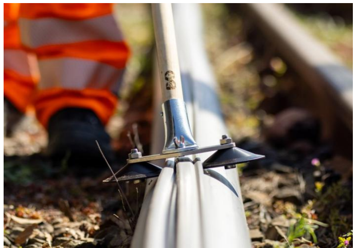
4. Rohr mit Verschlussbesen schliessen
