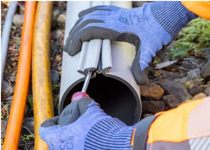
1. Verschluss mit Schraubenzieher aufdrücken
