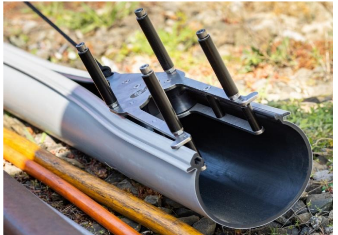
2. Schlitten in das Rohr einziehen
